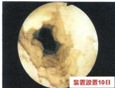
①排水管内がスケールで閉塞寸前の状態
